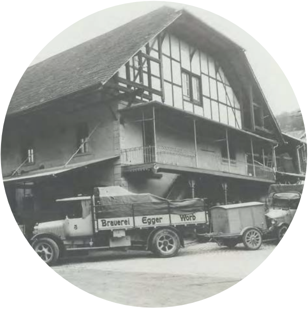
Die Hauptfassaden des Brauihauses werden wieder freigestellt
